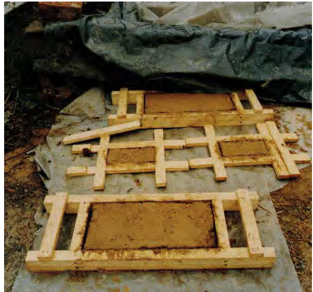
Úsáideadh brící láibe, a cruthaíodh i múnlaí adhmaid, chun codanna lofa den bhalla láibe a dheisiú (An Chomhairle Oidhreachta)
