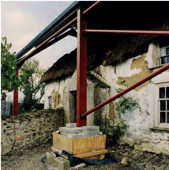
Tógadh seid chosantach shealadach os cionn an fhoirgnimh chun na hoibreacha caomhantais a éascú (An Chomhairle Oidhreachta)
