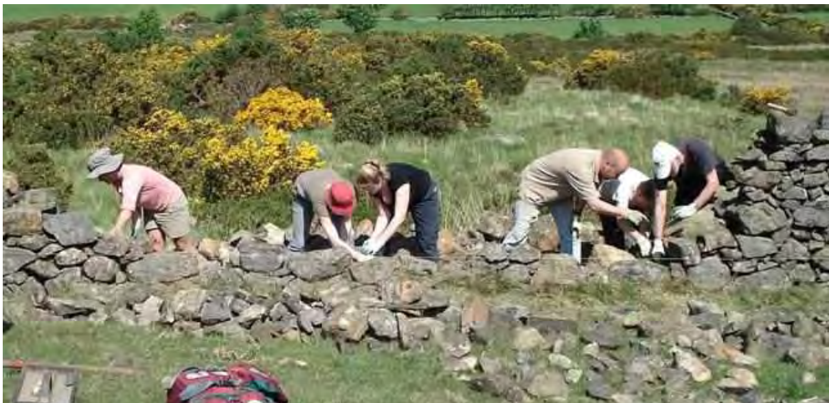
Oibrithe deonacha ag deisiú balla páirce, Beanna Boirche, Co. an Dúin (lontaobhas Oidhreacht Mhúrn)
