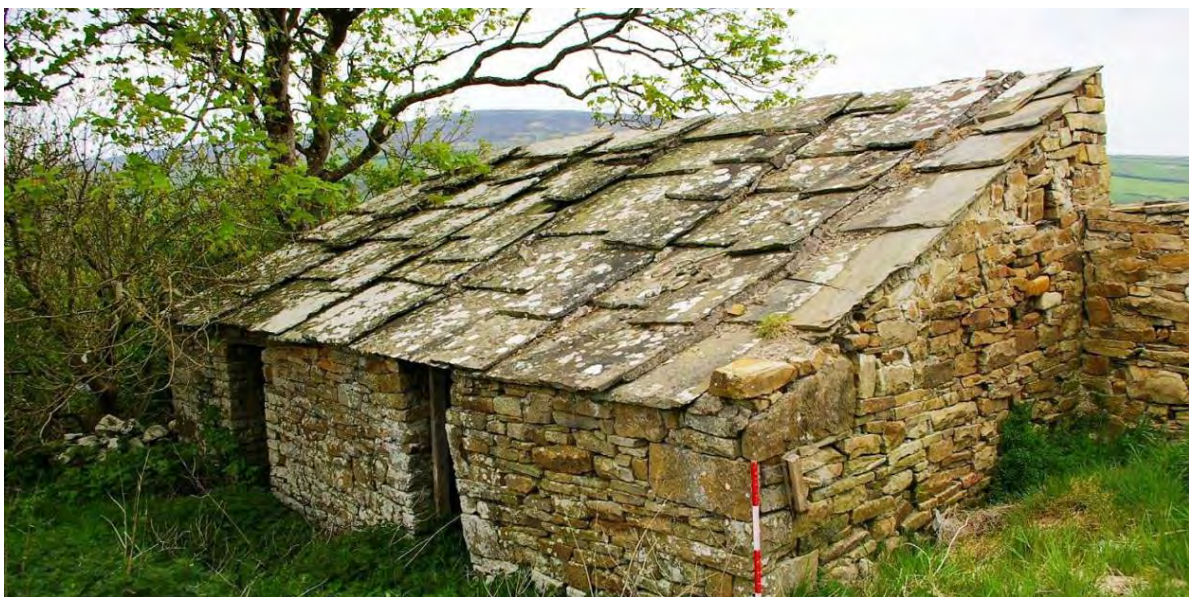
Foirgneamh feirme agus díon déanta as leaca cloiche air, Baile an Chaisleáin, Co. Mhaigh Eo (Sarah Jane Halpin)
