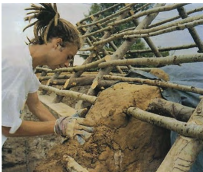
Balláí láibe á ndeisiú, Maigh Ghlas, Co. Loch Garman (Coláiste na hOllscoile, Baile Átha Cliath)
