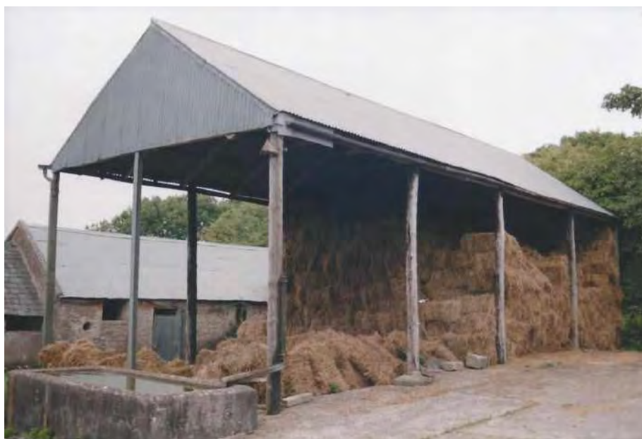
Scioból agus tréithe dúchasacha air, le tacaí déanta as cuailí adhmaid, Maide Buí, Droichead Barrington, Co. Luimnigh (Barry O'Reilly)
