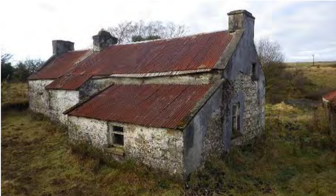
Teach ar a bhfuil díon iarainn rocaigh, Bóthar Scraghy, Caislen na Deirge, Co. Thír Eoghain agus, mar ba ghnách sa réigiún sin, tá spás do leaba starrtha le feiceáil ar chlé (RCSARP)
