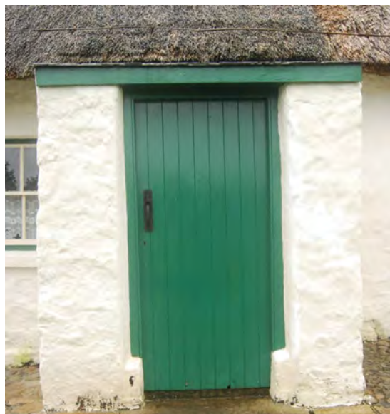
Scáthlán gaoithe agus doras déanta de chláir adhmaid, Ros Muc, Co. na Gaillimhe (FNOA)
