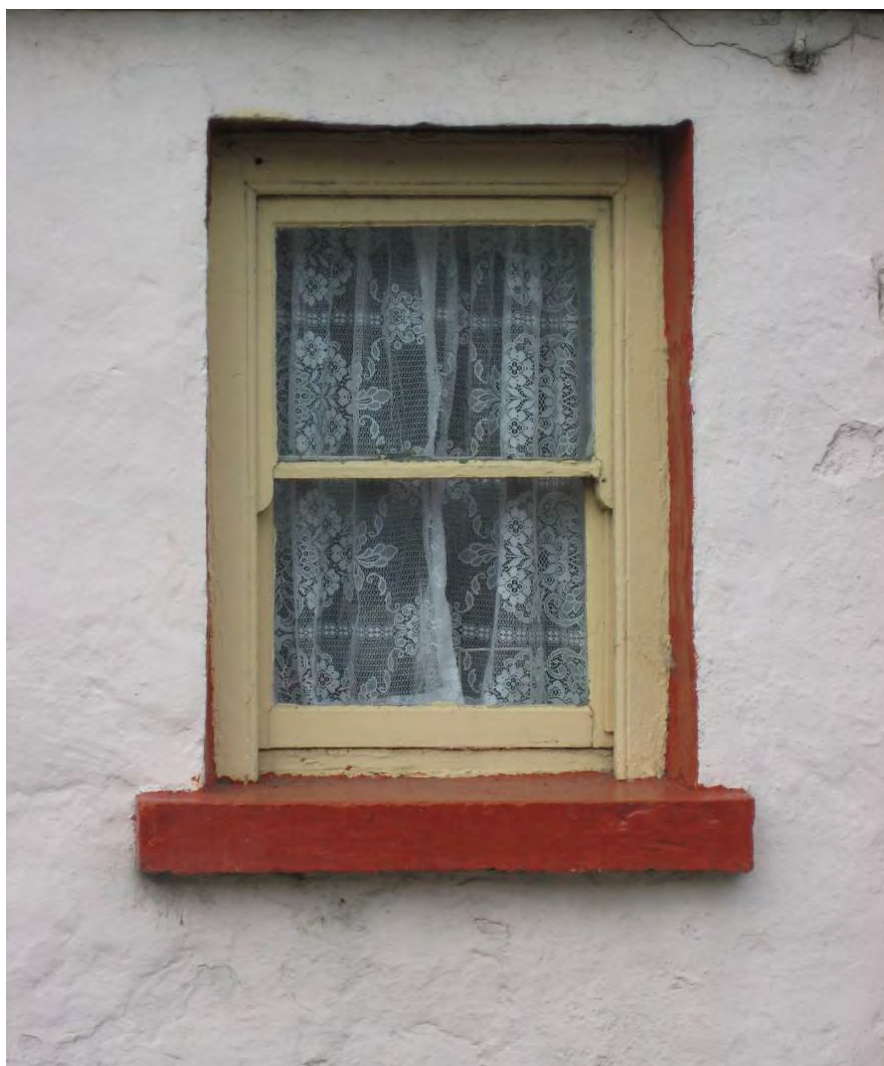
Gnáthfhuinneog le sais sleamhnáin adhmaid, Sráid Chnoc an Tobair, Cathair na Mart, Co. Mhaigh Eo (FNOA)
