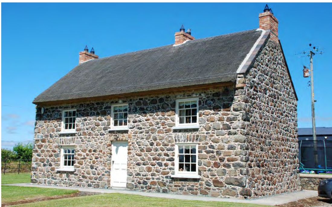
Ballaí basailt i gcúrsaí, agus ceann tuí, Bóthar Scroggy, Cromghlinn, Co. Aontroma (RCSARP)
