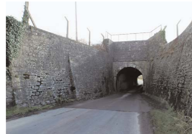
(fig. 25) BLUNDELL AQUEDUCT Edenderry (1793)
