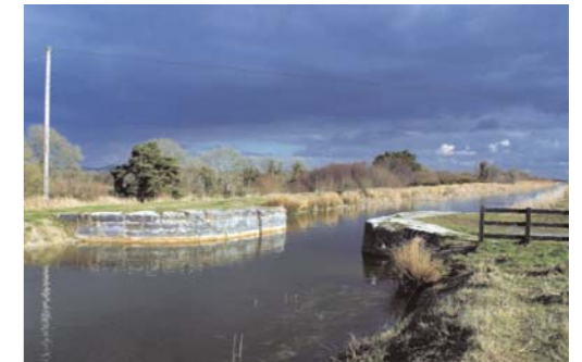
(fig. 26) BLUNDELL AQUEDUCT
