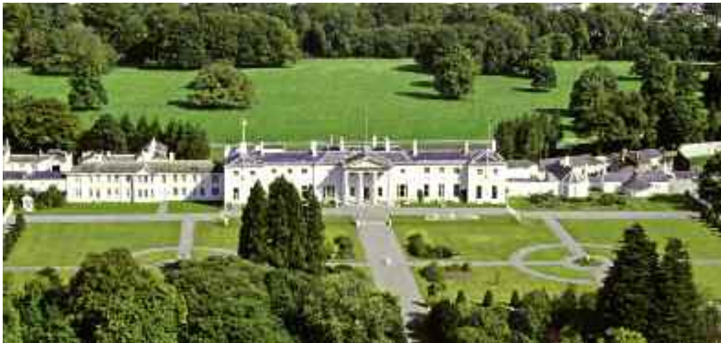
( fig. 40 ) ÁRAS AN UACHTARÁIN Phoenix Park (1782)
